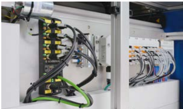
Bild 6: Die Safety Fieldbox vereinfacht die Integration von Sicherheitsschaltgeräten in den Sicherheitskreis
